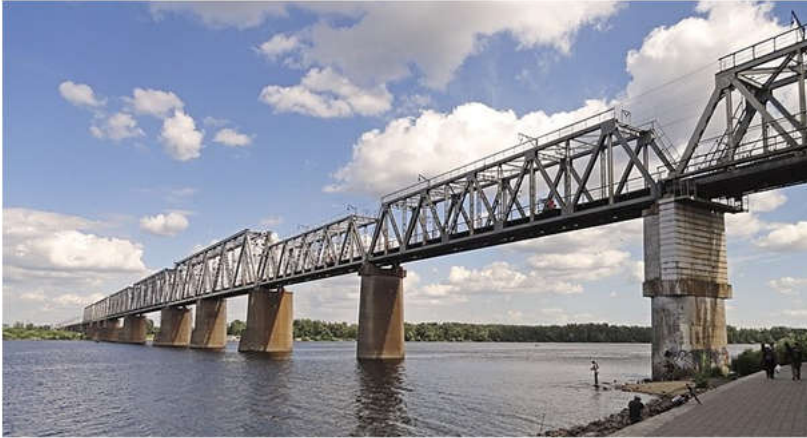
Рис. 6. Петровский мост (современный вид)
