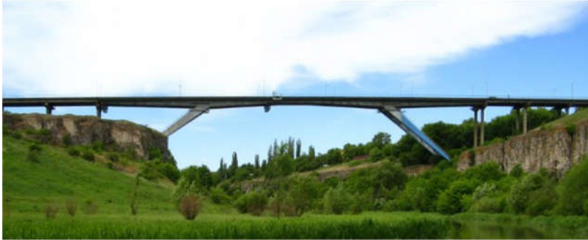
Рис. 22. Мост через р. Смотрич
