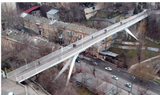
Рис. 23. Мост через спуск Жанны Лябурб
