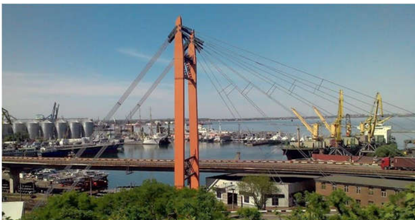
Рис. 19. Мост в морском порту г. Одессы
