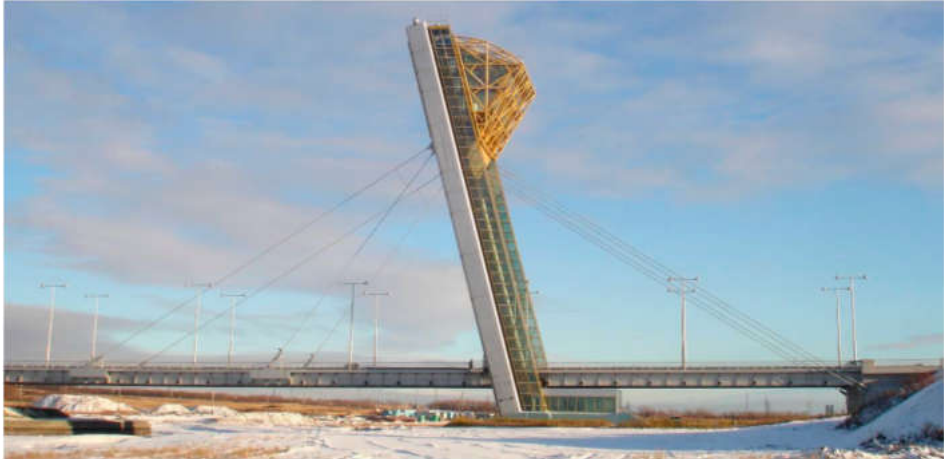
Рис. 30. Мост в г. Селехарде
