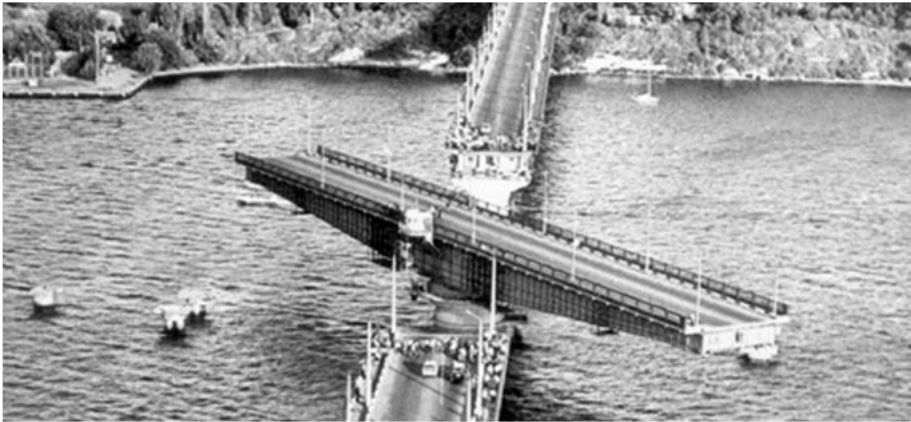
Рис. 21. Поворотное строение городского моста в г. Николаеве
