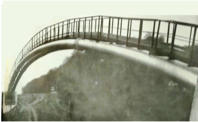
Рис. 33. Арочный переход на нефтепроводе «Дружба»
