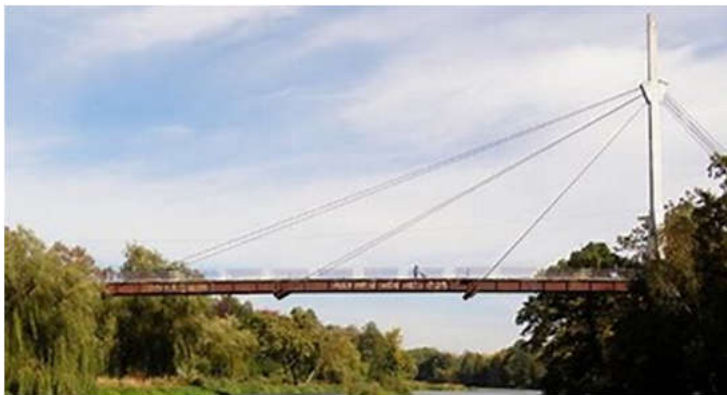
Рис. 15. Мост в г. Коростене
