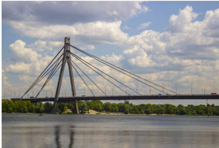
Рис. 16. Московский мост в г. Киеве
