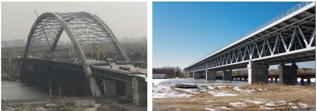
Рис. 26. Подольский мостовой переход: слева мост через р. Днепр (завершается строительство), справа мост через р. Десенку (построен в 2008 году)
