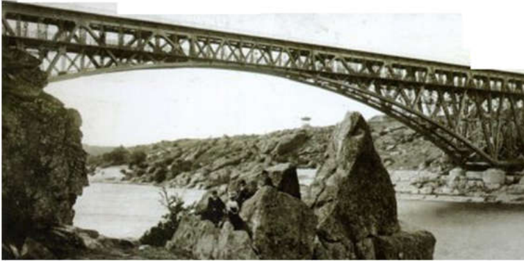
Рис. 4. Мост через р. Днепр у Кичкаса
